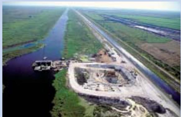
Las entradas y los trabajos de distribución del agua del STA 1 (siglas en inglés de "stormwater treatment area" o área de tratamiento de aguas de tormenta,) que es un humedal ampliamente construido donde se está tratando el agua de escorrentía de los campos de la caña de azúcar antes de entrar en los Everglades. Foto de los archivos del South Florida Water Management District.
